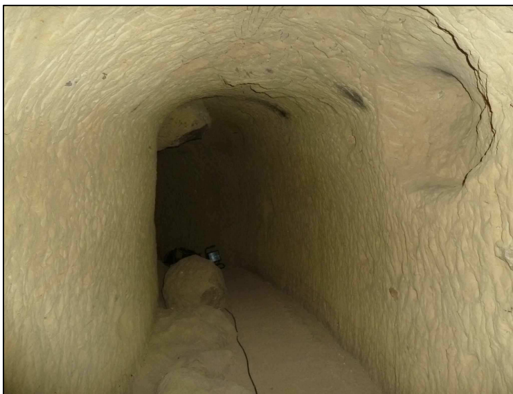
Vista general del corredor 3. S'observen alguns dels forats generats per l'extracció d'alguns blocs de pedra.
