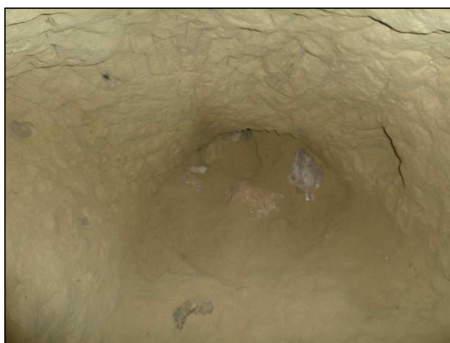
Vista de l'antiga sortida del pou de ventilació, avui tapada amb runa.
