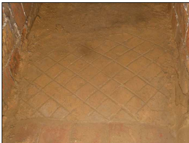
Detall del tram inicial del paviment de l'Espai 3 fet amb morter de calç amb un enreixat per evitar rrelliscades a causa del pendent. A la part interior el paviment és de morter llis.
