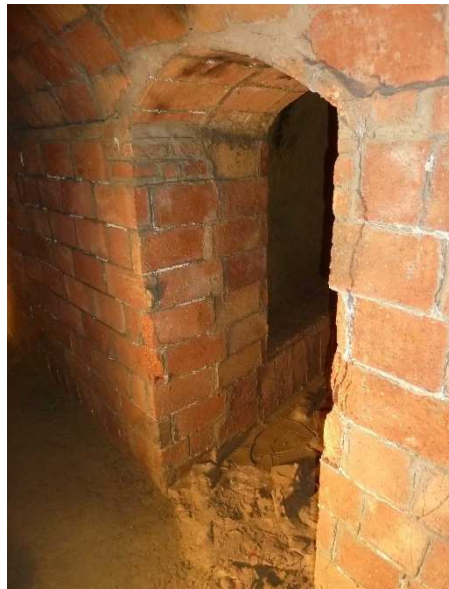
Vista de la porta de la sala
