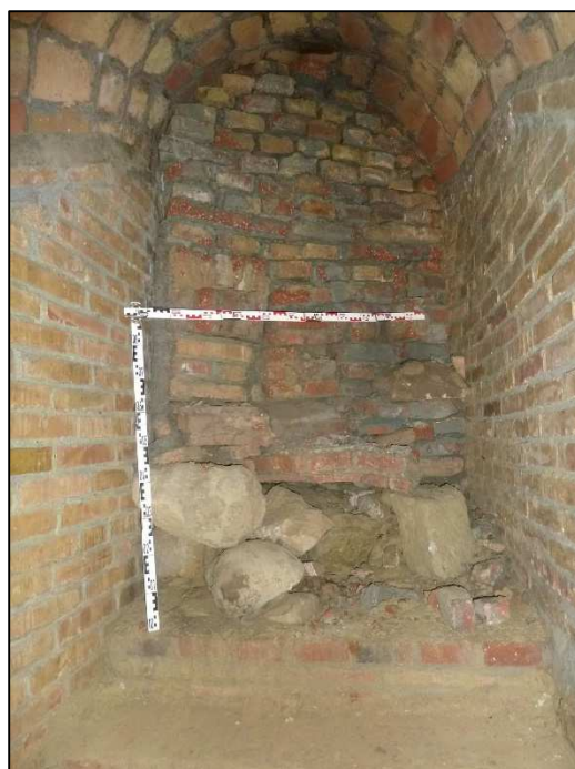
Vista del mur que tapiava la galeria, en un punt on sembla que aquesta iniciaria el darrer gir abans d'encarar la porta de sortida.
