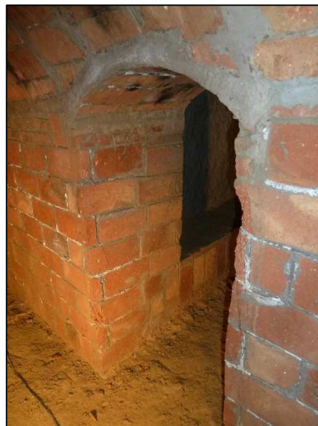
Vista de la porta de la sala
