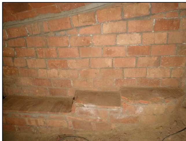
Detall de la bancada lateral i del revestiment de maons de la paret del corredor.
