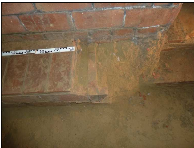
Detall de l'estructura interior d'un dels bancs al corredor 2
