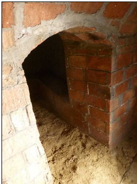
Vista de la porta de la sala
