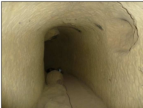
Detall d'una de les galeries encara sense revestir, s'observa el perfil general d'aquestes.
