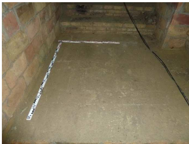
Detall del paviment de rajoles del segon replà
