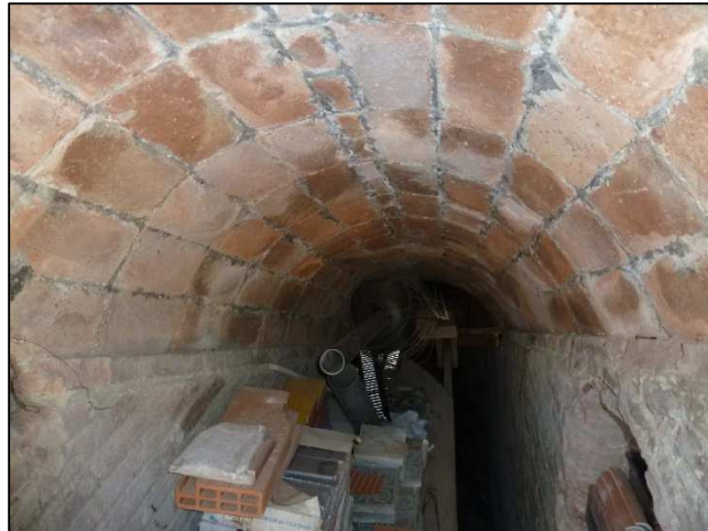
Vista de la volta de la galeria situada a la paret del pati de l'escola Montserrat.
