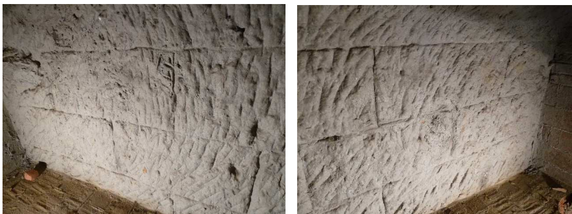
Detalls del fals carreuat decoratiu de les parets de la sala.
