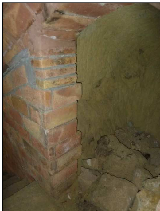
Vista de la porta d'entrada a l'espai 1 que està perfectament formalitzada mentre que l'espai interior està en procés de picat.
