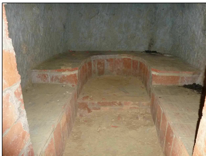
Vista de la bancada i del terra de la sala en la que s'observa el canvi de nivell documentat.
