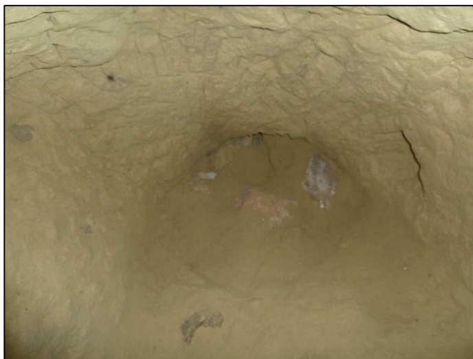
Detall de la continuació de l'obertura cap amunt i com la part alta d'aquesta, a partir dels 340 cm està tapada amb runa.
