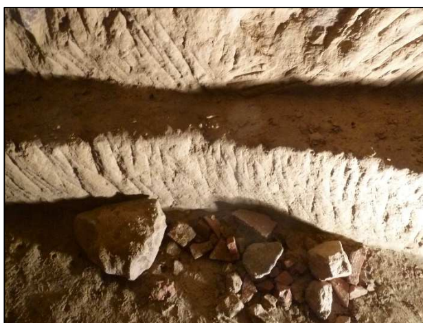
Detall de la bancada picada a la roca, s'observa la seva irregularitat que posteriorment es regularitza amb el revestiment ceràmic.
