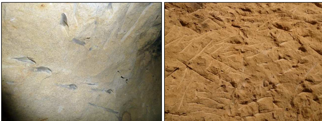
A l'esquerra traces dels cops de pic amb els que s'obria la galeria. A la dreta traces del repicat final amb piqueta.
